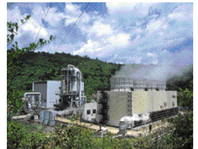
鬼首地熱発電所(宮城県)
