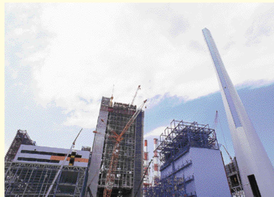
磯子火力発電所リブレース工事
