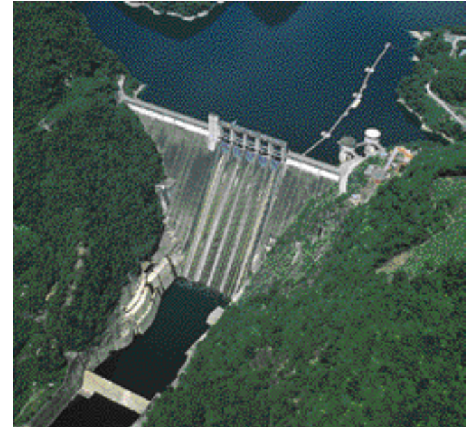
佐久間発電所(静岡県)
