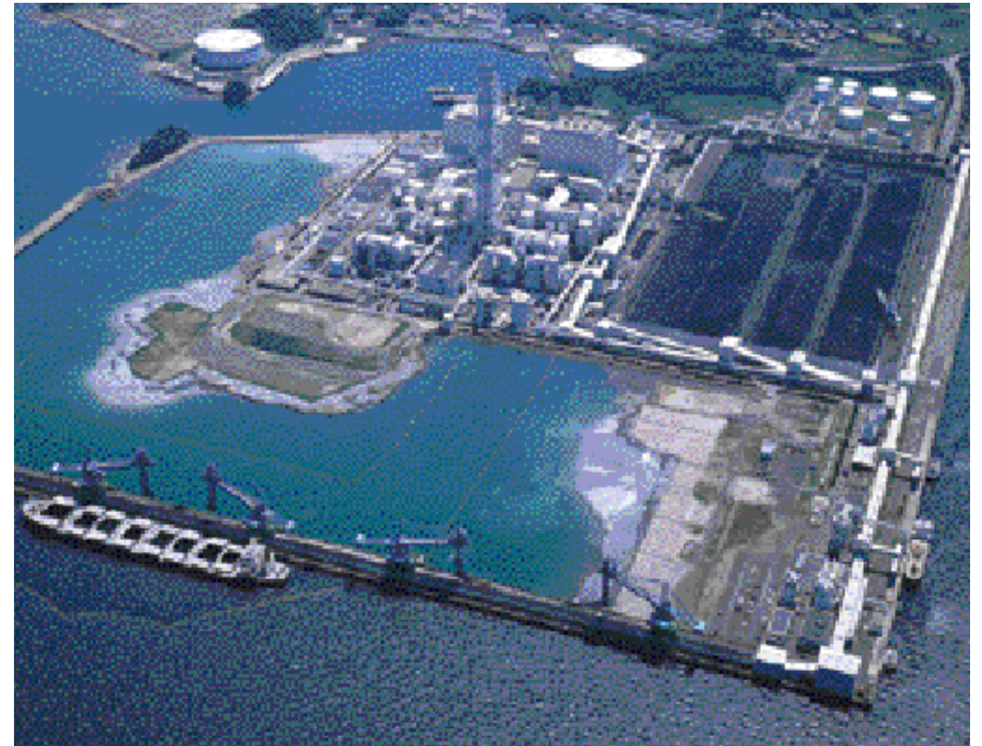
松浦火力発電所(長崎県)
