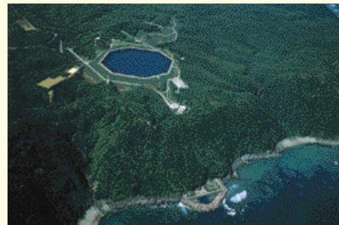
沖縄やんばる海水揚水発電所(沖縄県)
