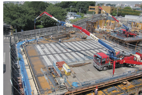
図 - 22 2010 年 8 月 PCa 梁敷き込み
