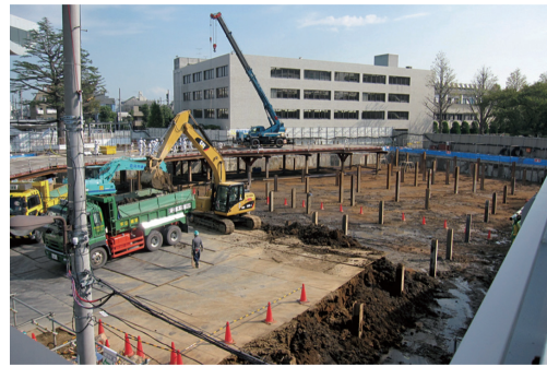
図 - 20 2009 年 9 月 掘削状況
