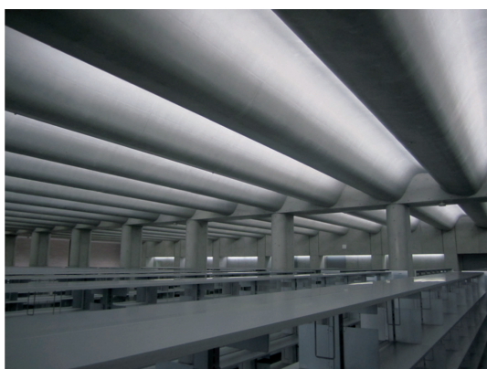
図 - 26 地下 1 階閲覧室変型 PCa 梁
