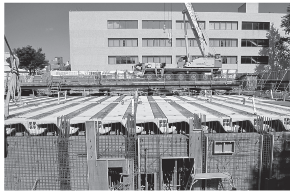
(b) 現場設置時
