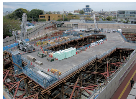
図 - 21 2010 年 4 月 地下躯体工事
