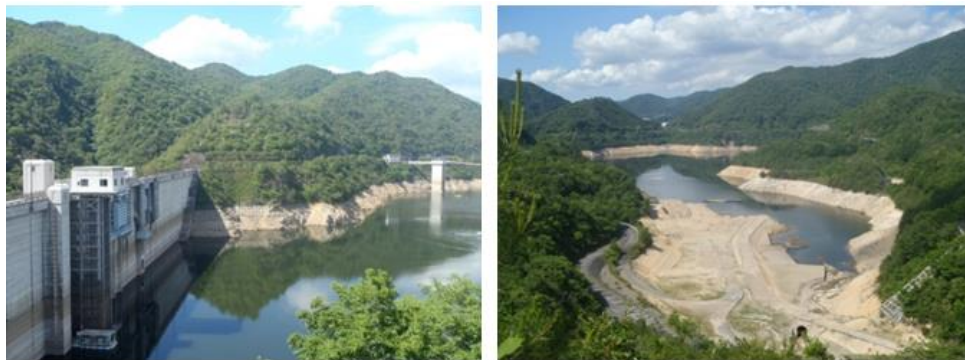
第5.2図 2013年6月13日八田原ダム（広島県）の下流部（左図）と上流部（右図）貯水率40.6%（国土交通省 中国地方整備局提供）
