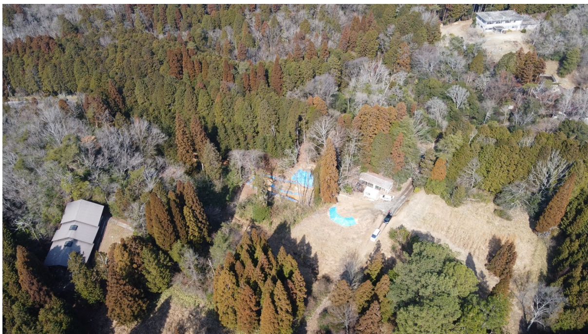
猿投山北断層東白坂トレンチ周辺の空撮写真 UAV を用いて上空から撮影（撮影者：鈴木康弘）
