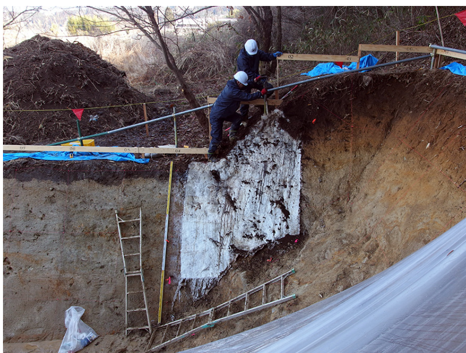
図 15 トレンチ壁面の剥ぎ取り標本作成作業
