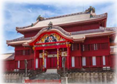
首里城の復元整備
