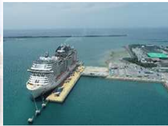
那覇港第二クルーズバースの整備
