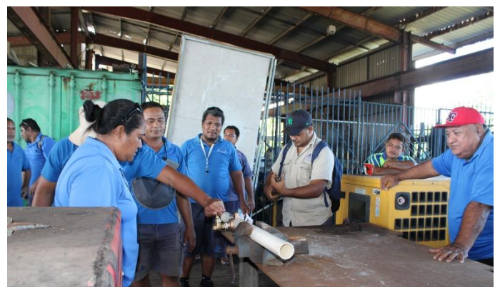
タッピングギア(穿孔機)によるサドル分岐実習
