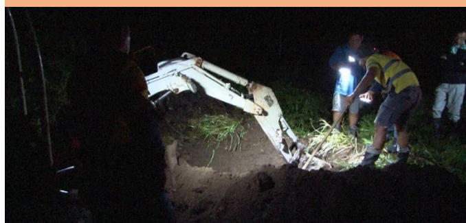
22:00 管路掘削開始
