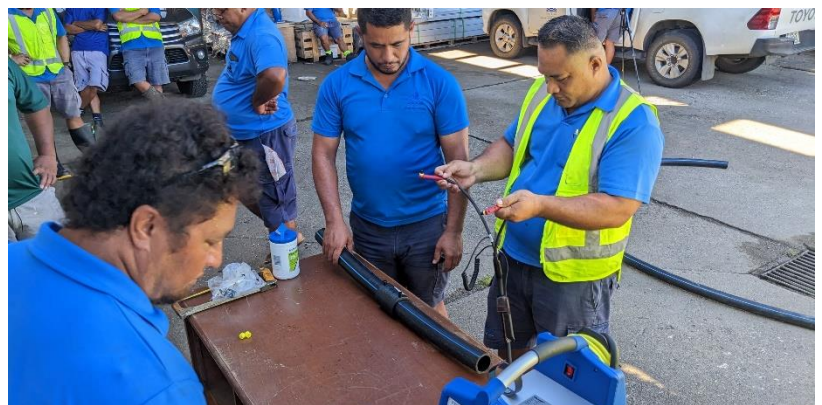
PE管の融着実技演習
