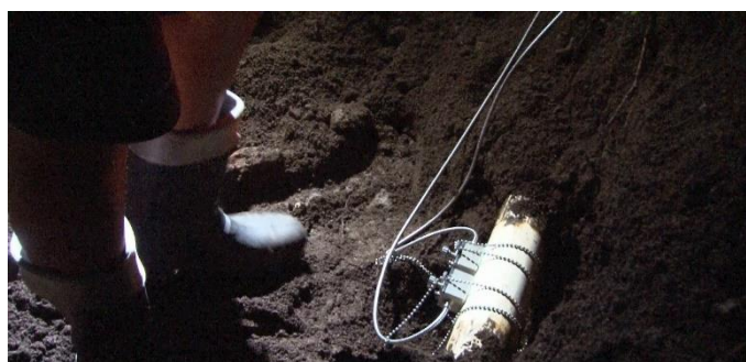
23:00 超音波音波流量計設置
