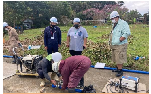
名護市:配水管布設更新工事現場視察
