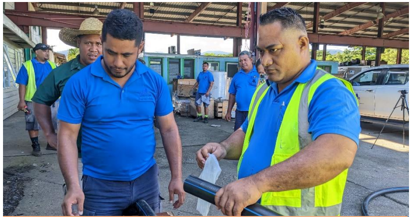
PE管の融着前のクリーンアップ
