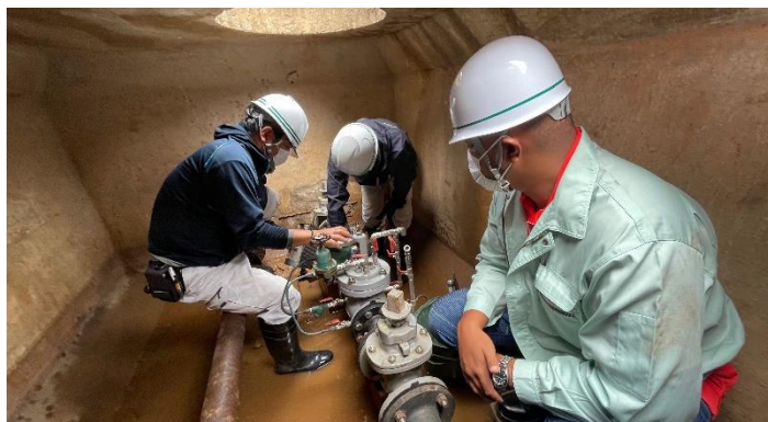
名護市:減圧弁の点検と清掃
