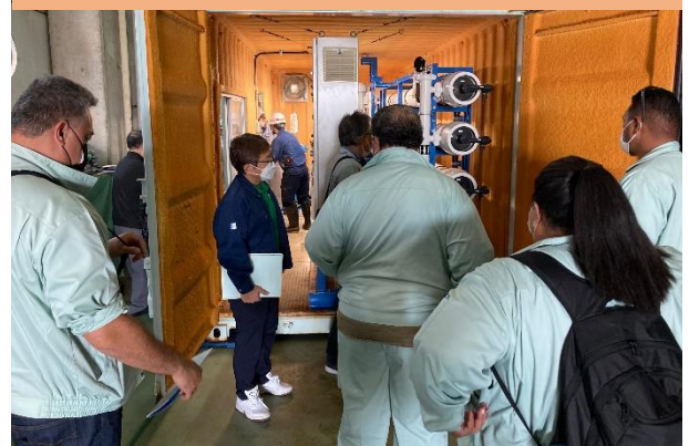
沖縄県: 海水淡水化システム
