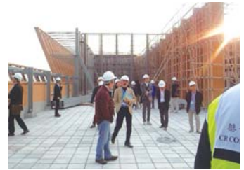
▲珠海学院 新校舎 建設現場視察
