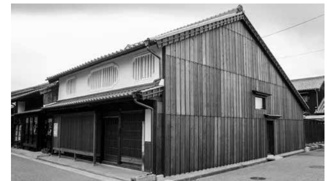
▲過去の資料を参考に復元された外観(修理後)(亀山市提供)
