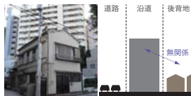
fig2. 個別更新による延焼遮断帯の現状 (写真: 墨田区, 明治通り)
