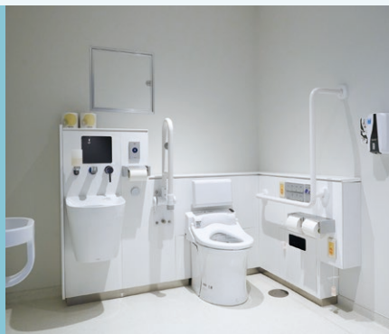
トイレ* 改修前は女性のトイレ行列ができていたことから、女性トイレの数を倍増。車椅子の方などにも対応する多機能トイレも新設しました。
