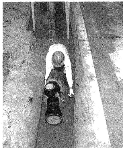
写真 NS形ダクティル鉄管の施工
