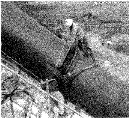
写真—4 管据付け
