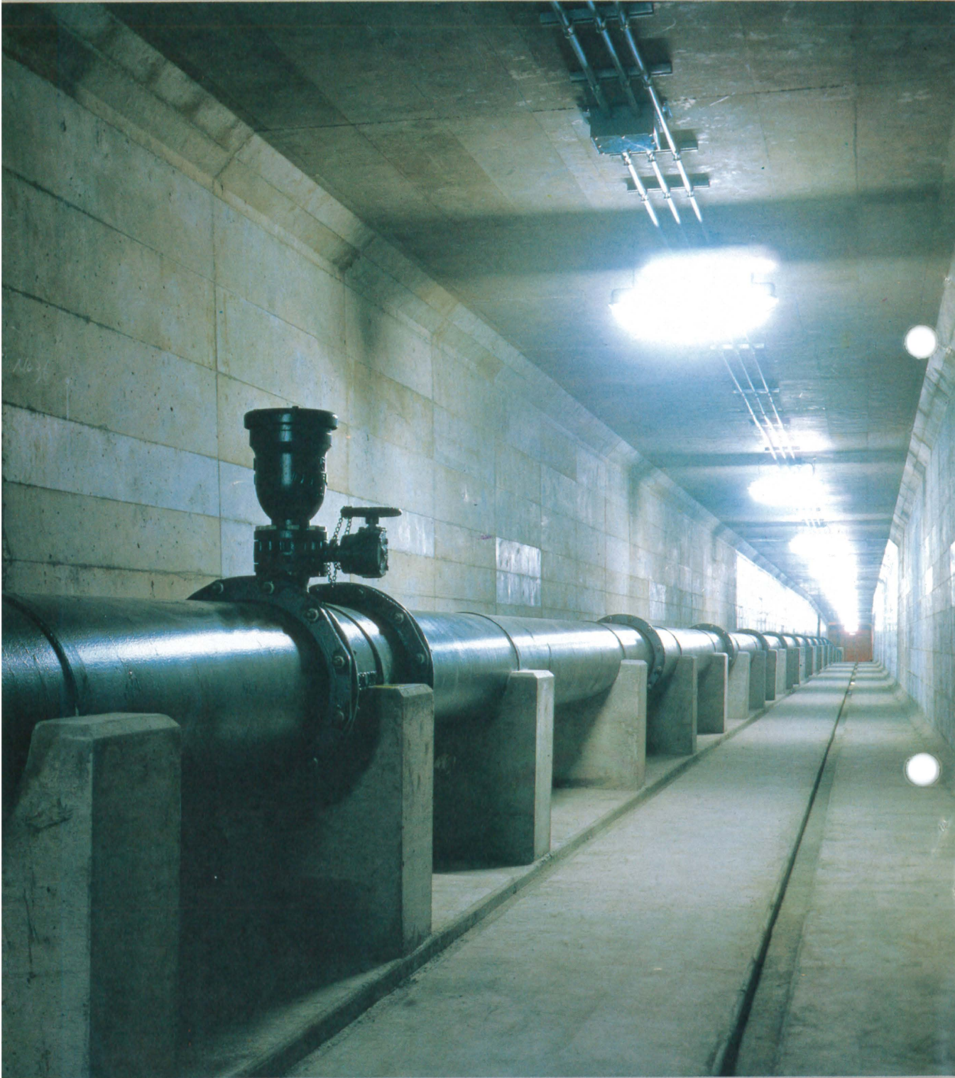
● 八王子市水道部 「八王子共同溝」の溝内送水管布設工事に使われたK形口径400mm 2種ダクタイル鉄管
