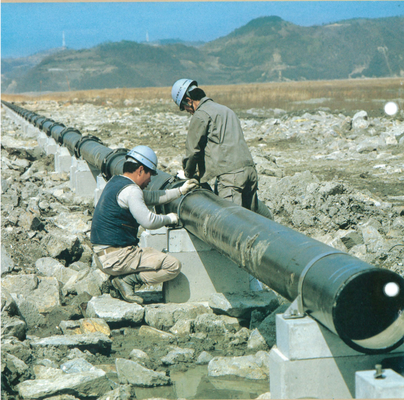
● 笠岡市水道局 笠岡湾干拓地の離島簡易水道事業に使われたSII形口径300mm 3種ダクタイル鉄管
