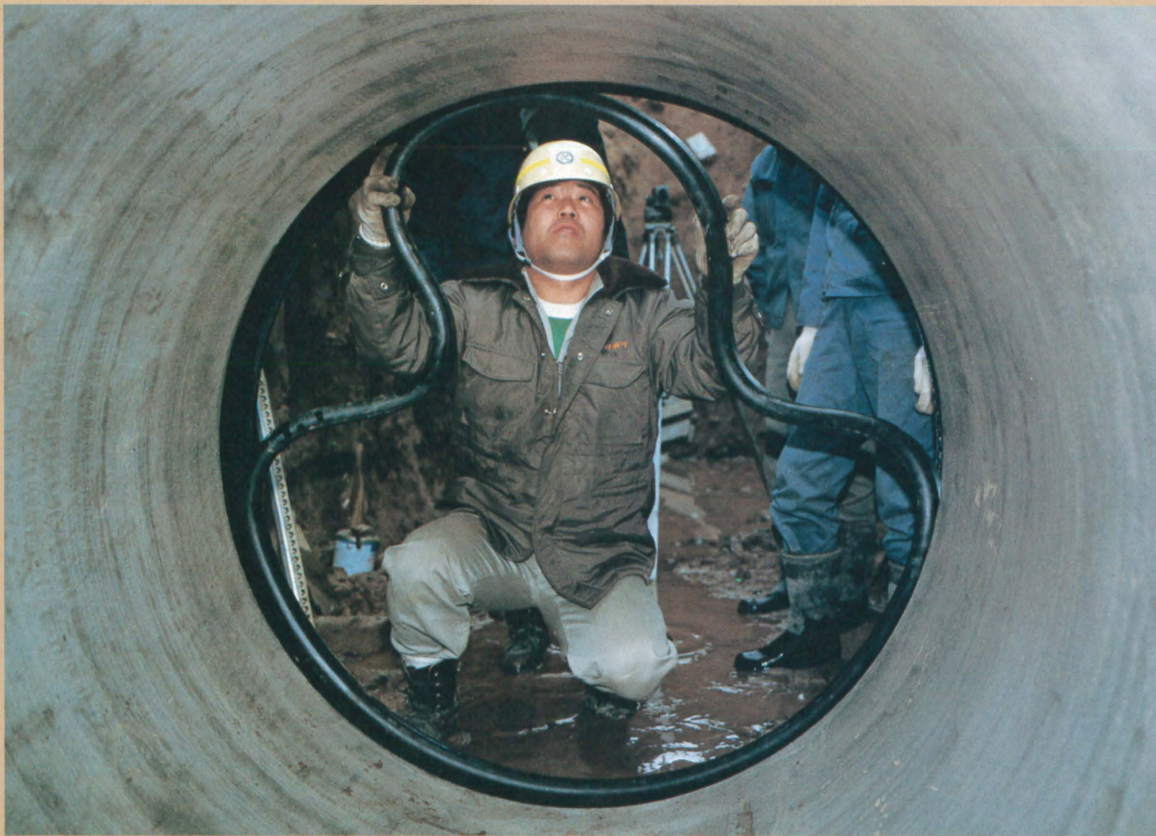
● 総社市都市開発部下水道課 放流管に使われたT形口径1100mm 5種ダクタイル鉄管
