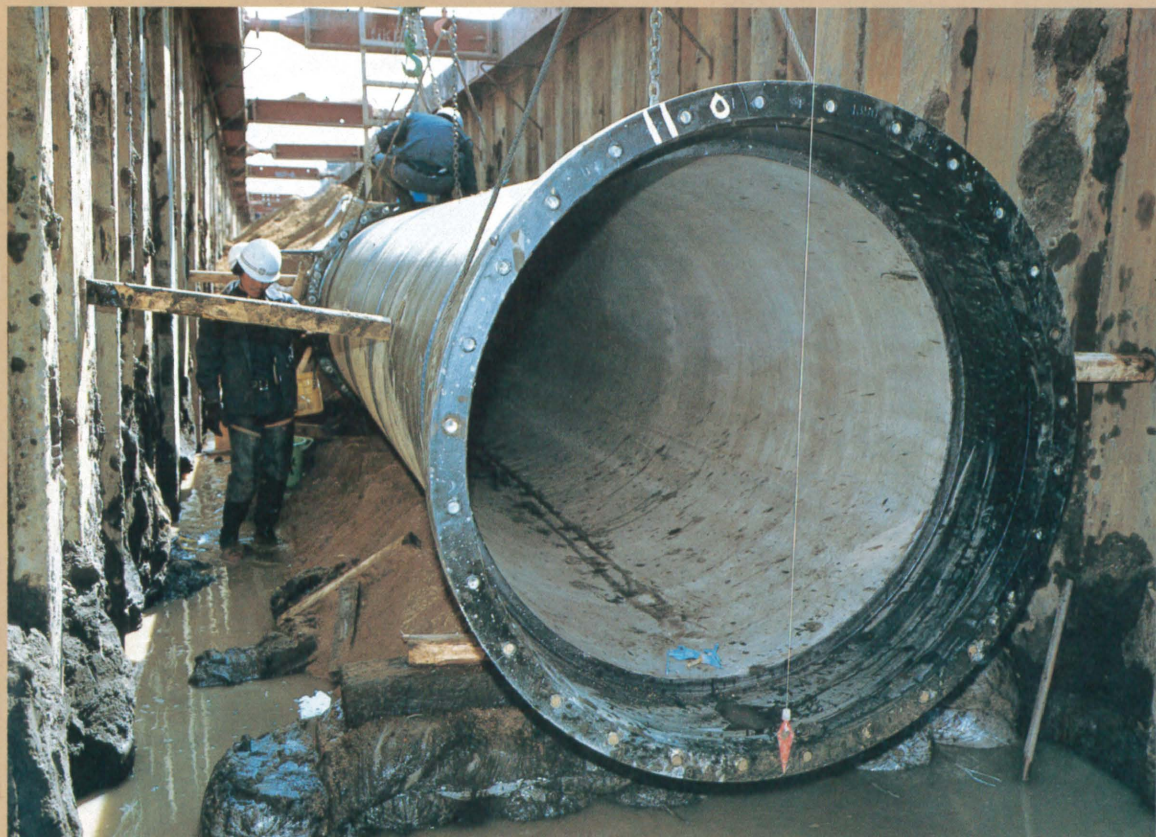
● 熊本市水道局 配水管布設工事に使われたS形口径1350mm 2種ダクタイル鉄管
