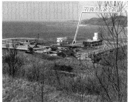
写真-1 口径100mm、200mm SⅡ形耐震継手管路布設場所
