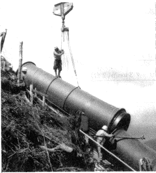
写真—3 管の搬送
