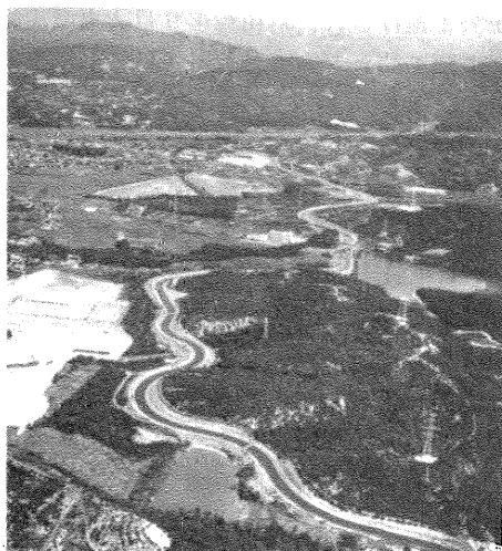
愛知用水：城東開水路
