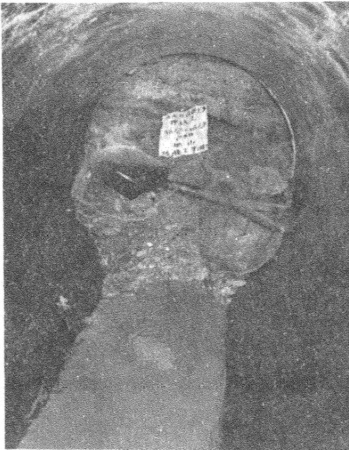
写真一七 タールエポキシコーティングされた圧入用鋳鉄管の切羽、下方に砂利層が見られる。
