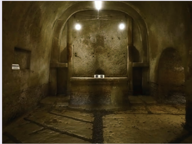
写真2 無窮洞の主洞部分
