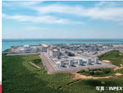
イクシスLNGプロジェクト
