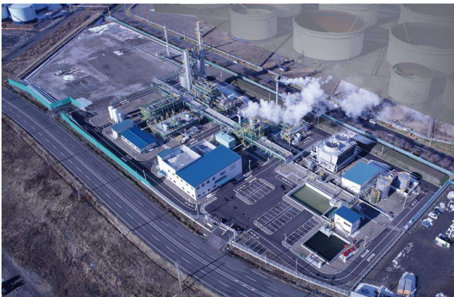
苫小牧CCS実証試験センター
