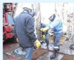
調査井掘削の様子
