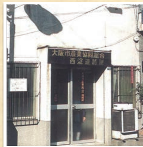
平成 18 年 3 月に東淀川支店と統合した【西淀連絡所】
