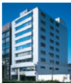
I-15 AOYAMA CRYSTAL BUILDING 青山クリスタルビル
