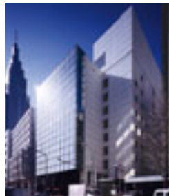
I-24 NIPPON BRUNSWICK BUILDING 日本ブランズウィックビル
