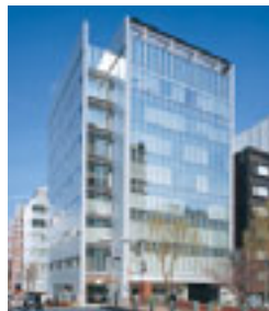
I-13 RYOSHIN GINZA EAST MIRROR BUILDING 菱進銀座イーストミラービル
