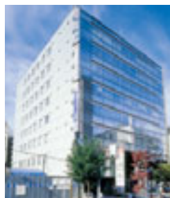
II-2 SAITAMA URAWA BUILDING さいたま浦和ビルディング
