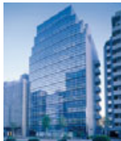
I-21 TAKANAWADAI BUILDING 高輪台ビルディング
