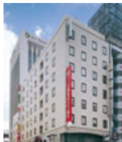
I-12 GINZA SANWA BUILDING 銀座三和ビル
