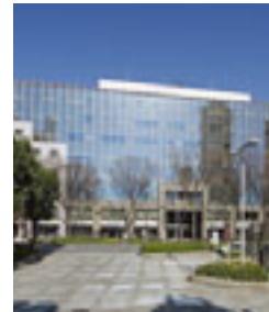
II-5 MUSASHI KOSUGI STM BUILDING 武蔵小杉STMビル
