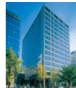
Ⅲ-12 MIDOSUJI DAIWA BUILDING 御堂筋ダイワビル
