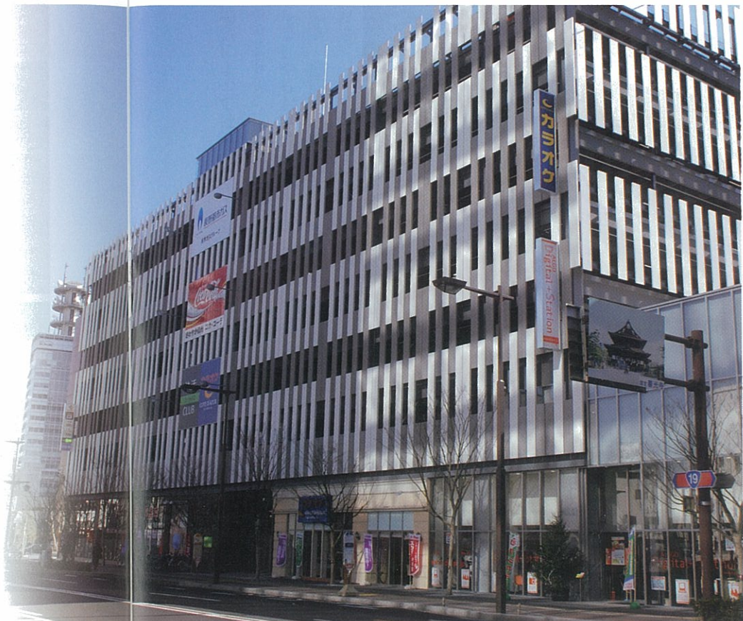
▲ TOiGOパーキングの外観。外装にも意匠をこらし、セメント押し出し成形板の白パネルを格子状に張り付けてある
