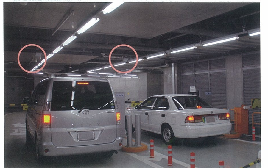
▼天井に取り付けられているDSRCシステム。円内がDSRC路側機
