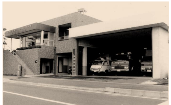
2代目大井出張所庁舎鉄骨ACL造2階建
