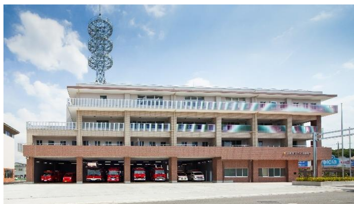
基礎免震、RC造4階建三代目の消防本部・西消防署
