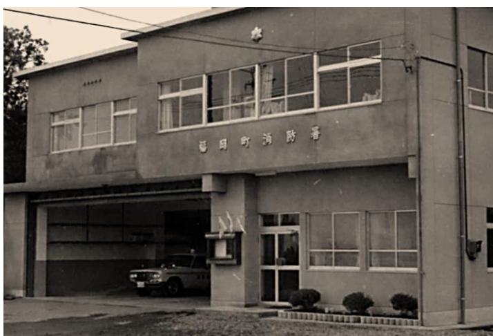
RC造2階建の初代消防本部・福岡町消防署庁舎
