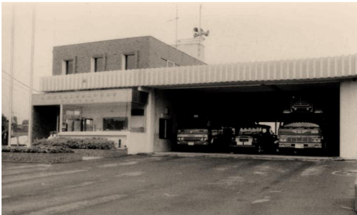
2代目富士見出張所庁舎鉄骨ACL造2階建
