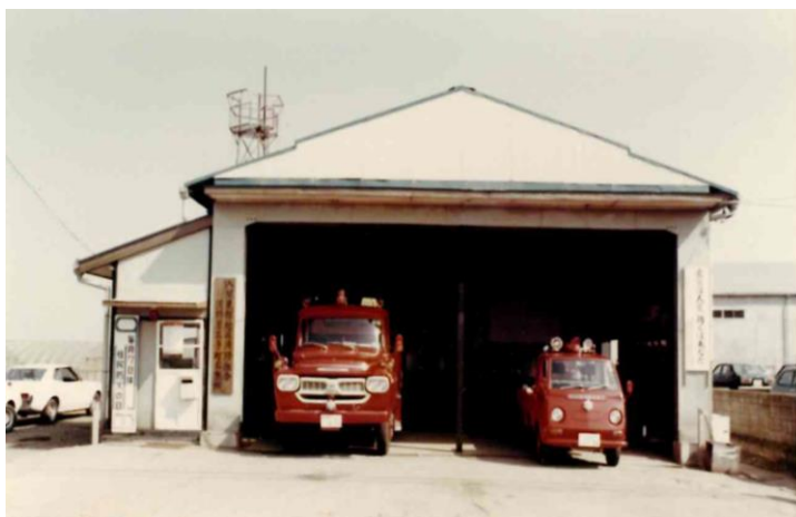
軽量鉄骨プレハブ造平屋建の三芳出張所仮庁舎
