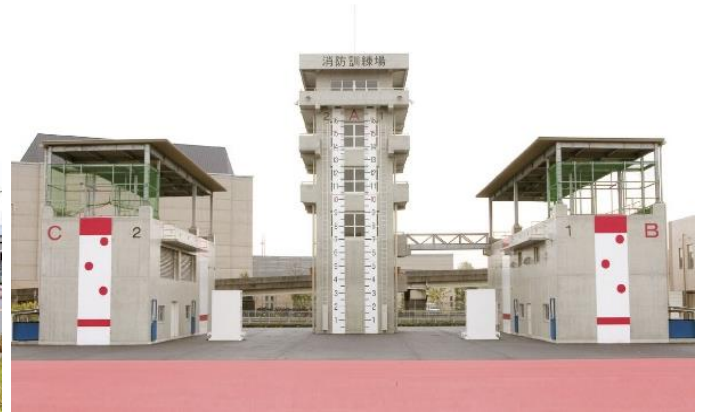
RC造6階建A棟、3階建のB、C棟の消防訓練場
