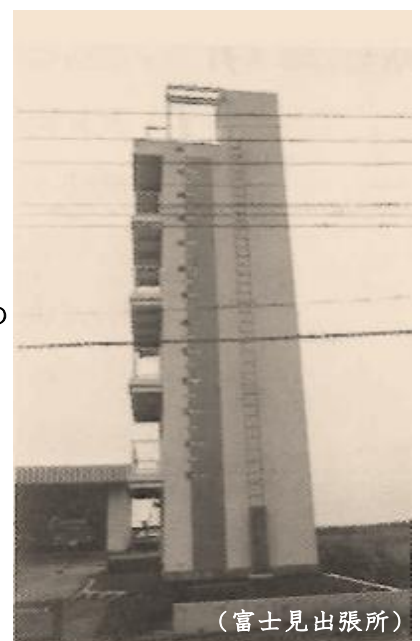
鉄骨ACL造訓練棟5階建
