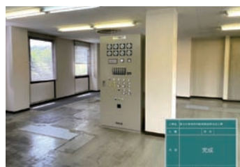
監視操作盤据付状況
