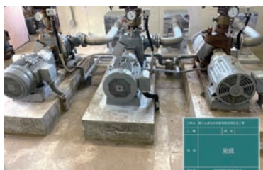
送水ポンプ・配管取替 完成
