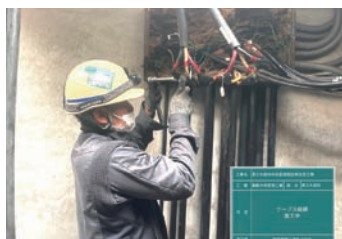
ケーブル結線施工中
