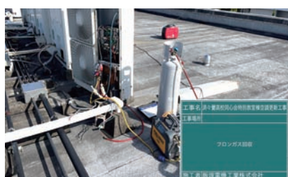
フロンガス回収作業状況
