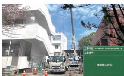
室外機搬入状況
