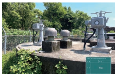
電動弁取替 完成
