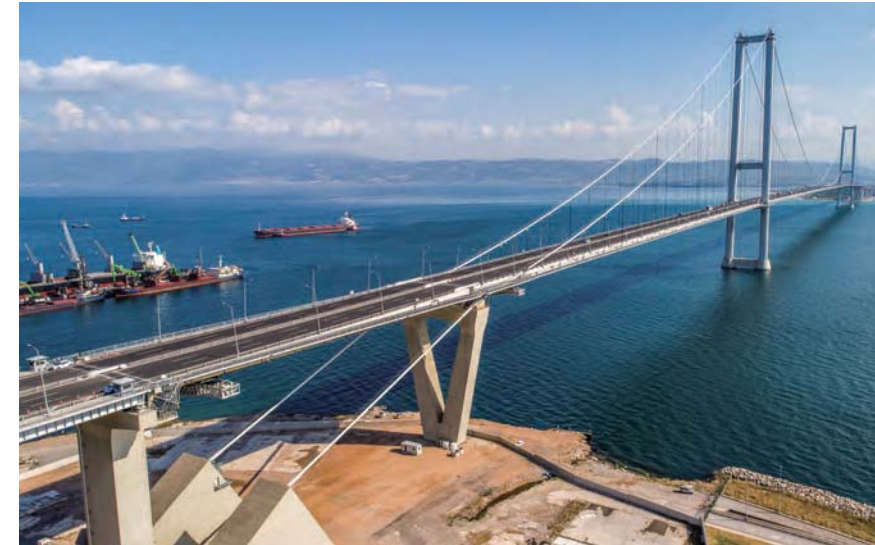
吊橋(オスマン・ガーズィー橋)
