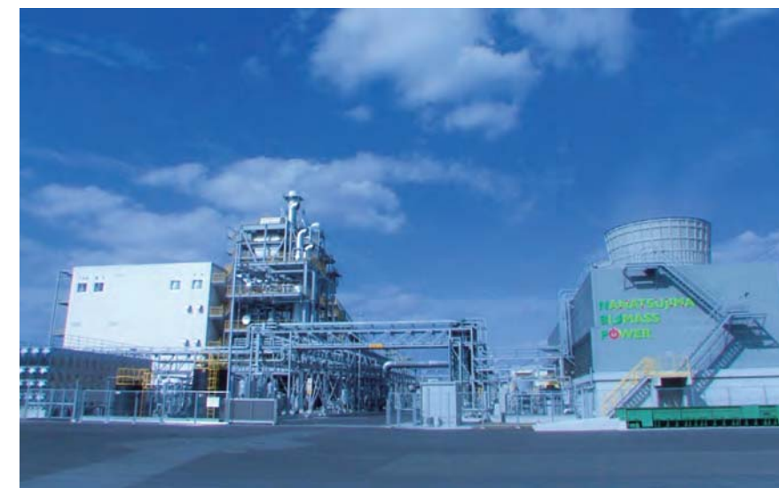
バイオマス燃焼技術 写真提供:七ツ島バイオマスパワー合同会社
