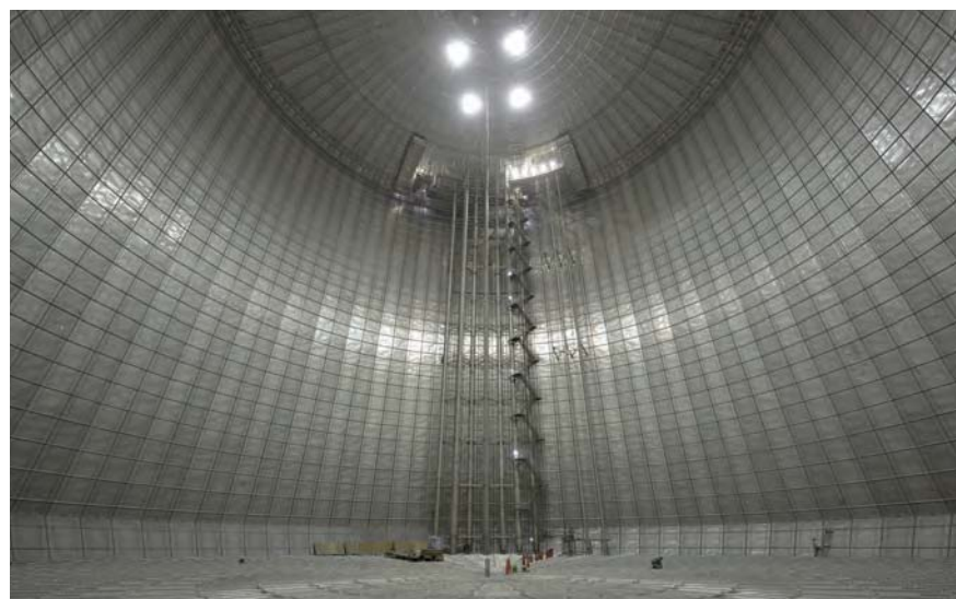
世界最大容量LNG地下タンク(メンブレン) 写真提供:東京ガス(株)
