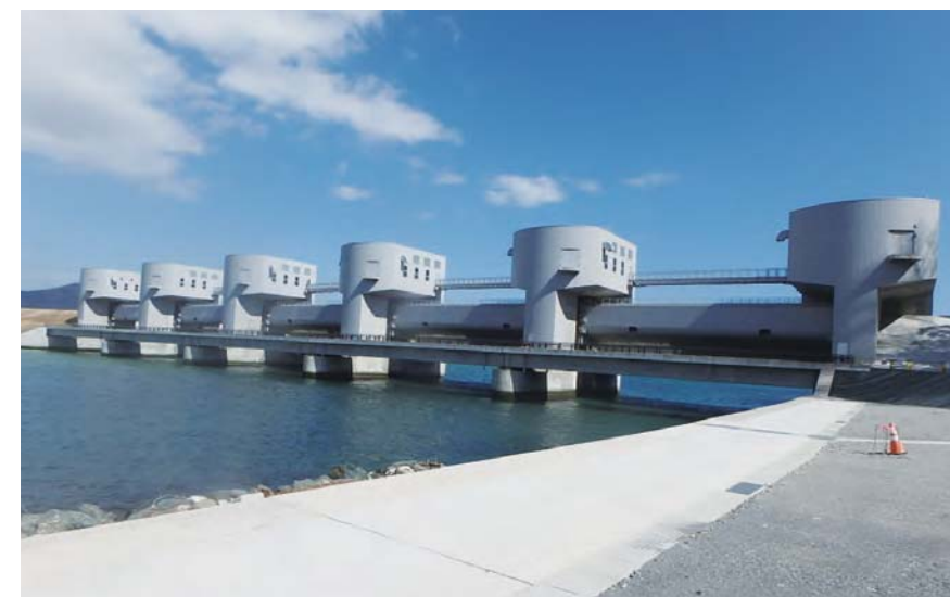
河川用ゲート(気仙川水門)
