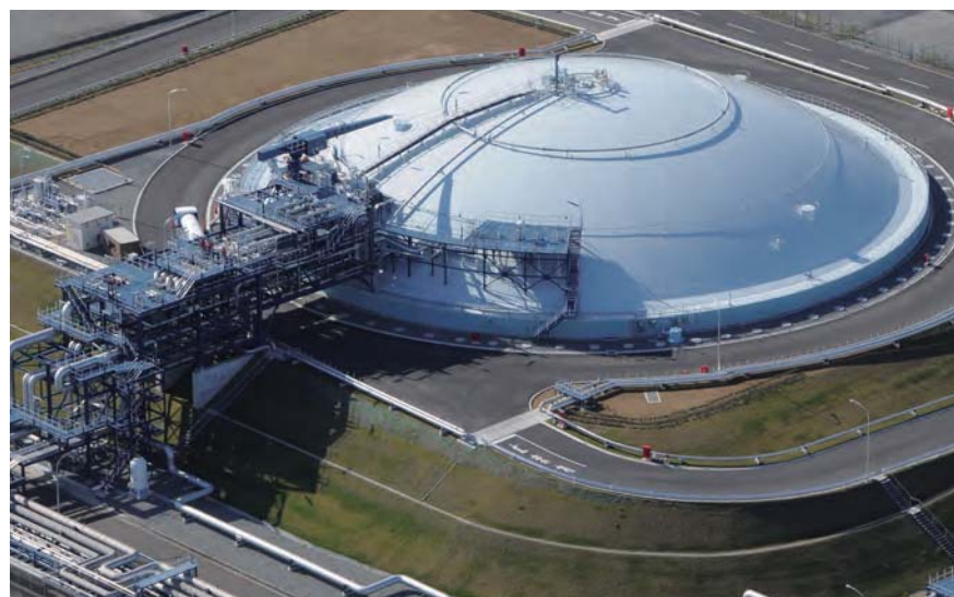
LNG地下タンク
