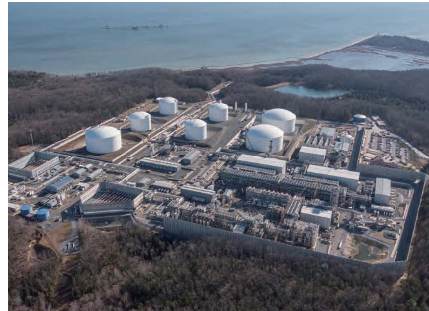
天然ガス液化プラント
