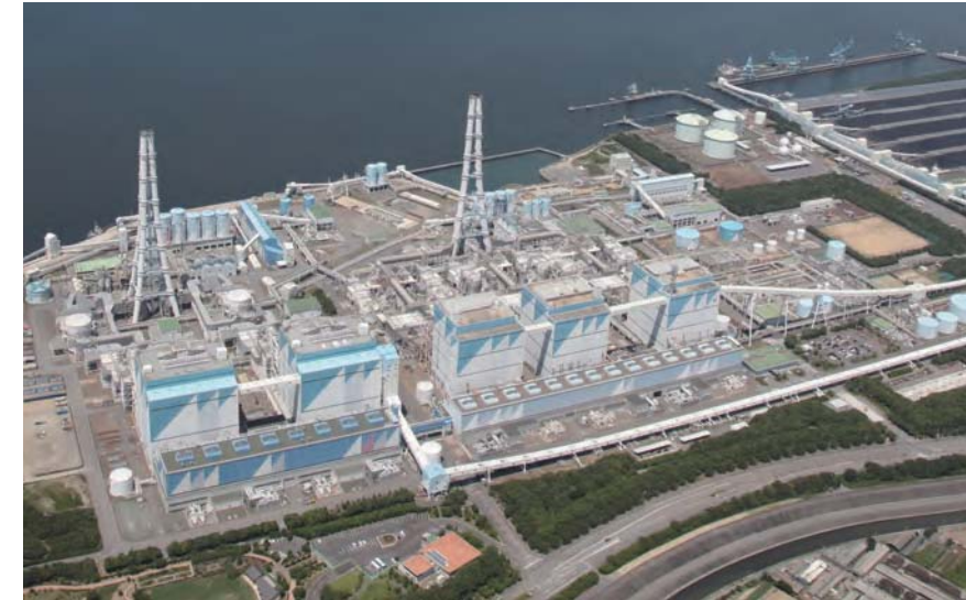
アンモニア燃焼技術 写真提供:株式会社JERA(碧南火力発電所)
