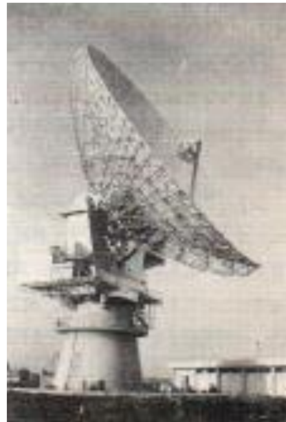
Intelsat-地球局アンテナ27.5m \phi (KDD茨城No.2, 1968年)(2)
