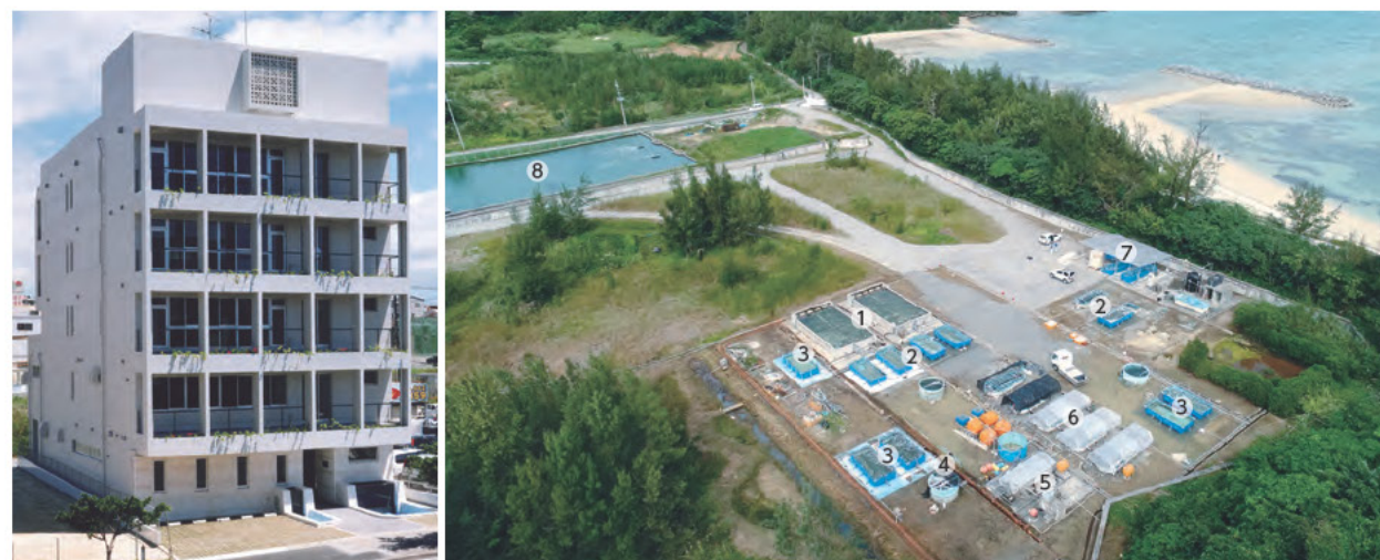
沖縄支社 2002年5月竣工 生物飼育実験室、生物検鏡・分析室、化学分析室、機器分析室、調査機材倉庫、研修室 併設
