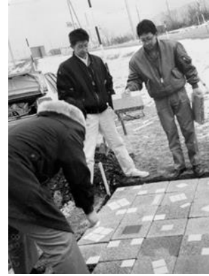
下水汚泥焼却灰を利用した透水ブロック施工試験
