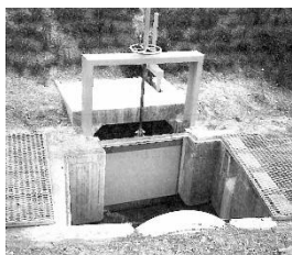
FRP 取水堰スライドゲート施工試験
