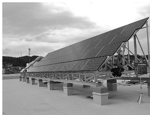
無落雪住宅向け太陽光発電架台
