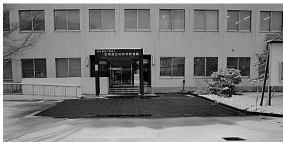
換気排熱を利用した融雪システム
