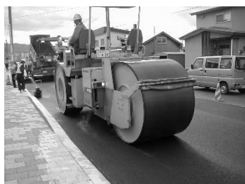
ホタテ貝殻粉末を利用したアスファルト舗装材
