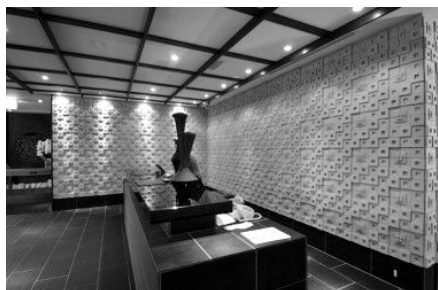
非焼成硬化技術を利用した調湿建材の製品化
