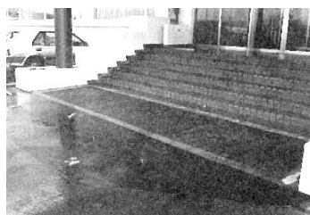
手稲汚泥焼却センターでの舗道用タイル施工試験
