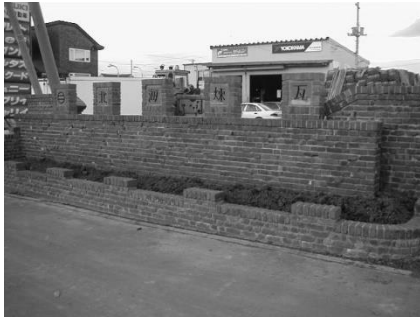
廃乾電池亜鉛滓を利用したレンガ施工試験
