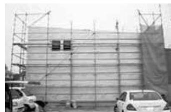
木質／無機質複合建材による胴縁の施工の様子
