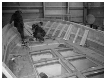
建造中の FRP 漁船
