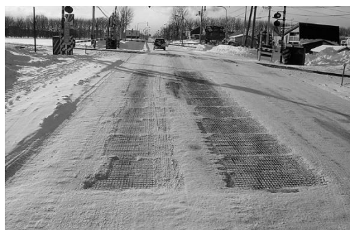
弾性体を用いた凍結路面防止パネル
