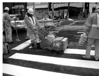
ホタテ貝殻を利用した路面標示用塗料の横断歩道施工試験
