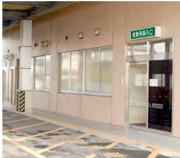
現在の病院の様子(救急室入口)
