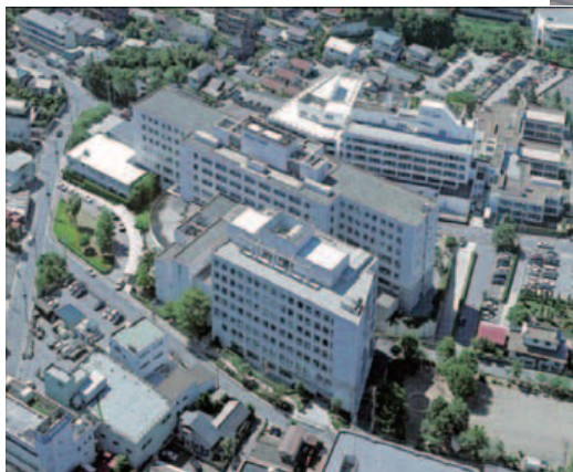
■病院全景（北西上空より撮影）
