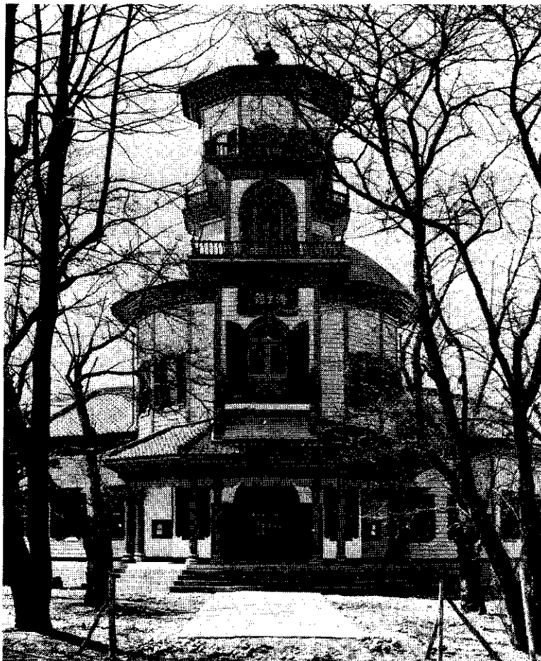
写真2 現在の三層楼
