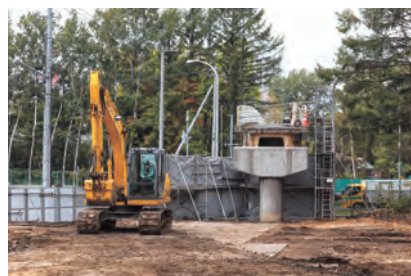
農学部側の工事の様子
