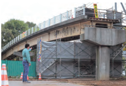
インターナショナルハウス側の工事の様子
