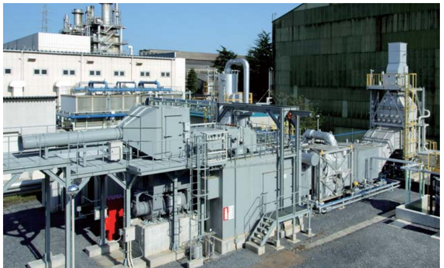
2 茨城県ひたちなか市の 4 MW 級試験プラント（AHAT-フェーズI）
