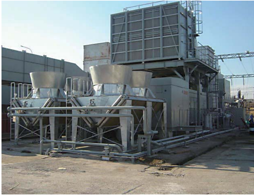
5 イラク共和国・モスル発電所に設置したH-25 ガスタービン発電設備(第3号機)
