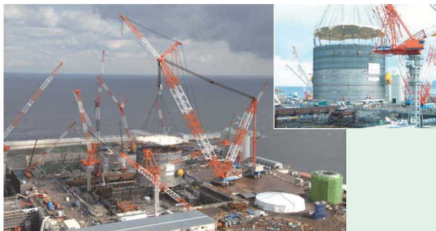
2 建設中の島根原子力発電所3号機 (大型クローラクレーンによる原子炉格納容器鋼製ライナー吊り込み状況)
