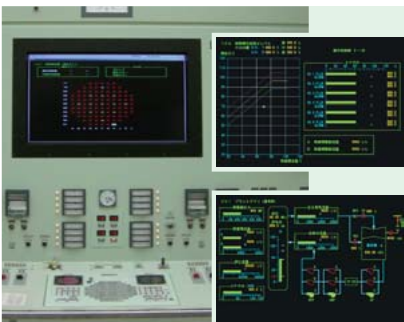
4 中国電力株式会社島根原子力発電所1号機の大規模監視ディスプレイ
