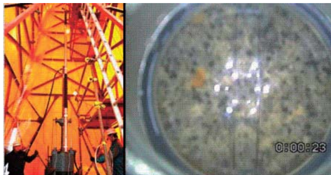
8 マイクロ化学プローブの挿入状況(左)とボーリング孔内(右)
