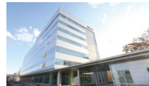
耐震化対策と設計改革・エコファクトリーを実現する那珂地 区の総合棟
