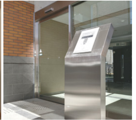
建物はオートロック式になっており、セキュリティにも配慮している
