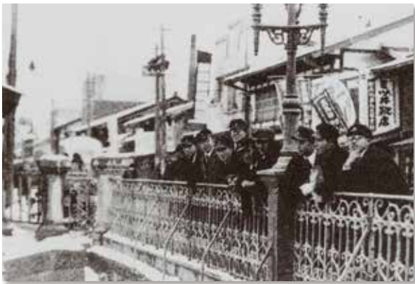
旧 下土手町蓬莱橋
