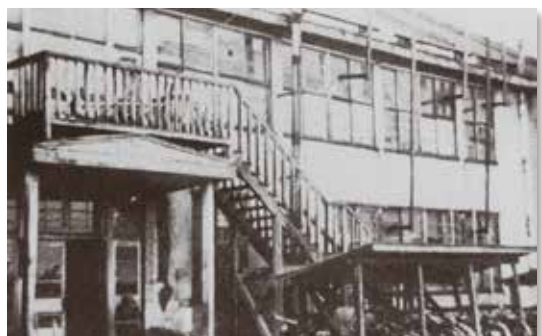
臨床研究棟入口 (昭和31年)
