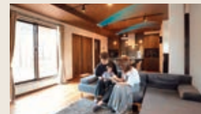
冷暖房中も窓を開けずに換気できる「Z空調」
