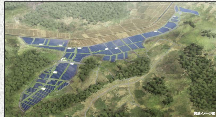
飯舘メガソーラー発電所設備構築
