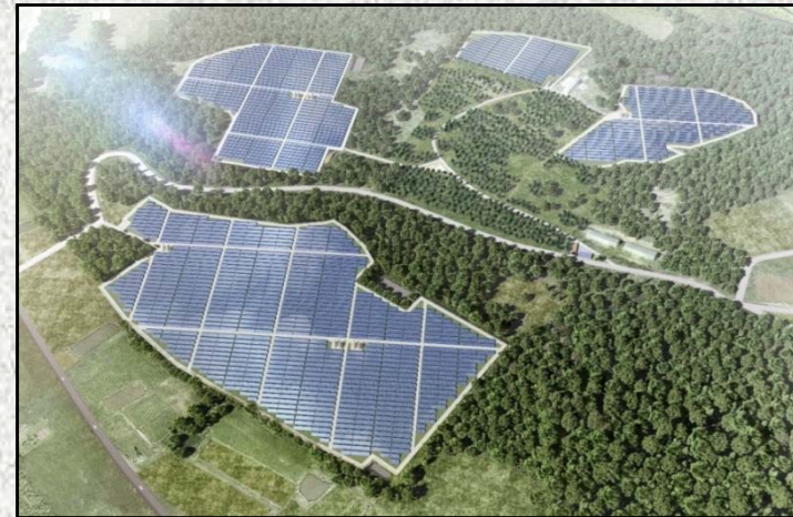
奥州メガソーラー発電所設備構築
