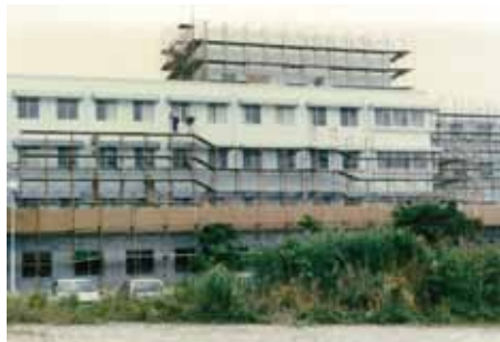
白十字病院からの改修工事スタート
