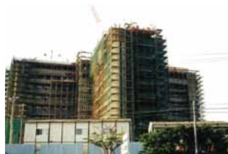
現:本館の増改築工事の様子
