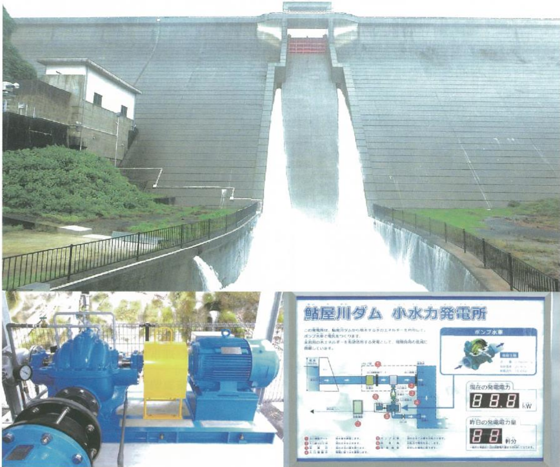
農業用ダムとして県下第1号となる小水力発電施設（洲本市鮎屋川ダム）
