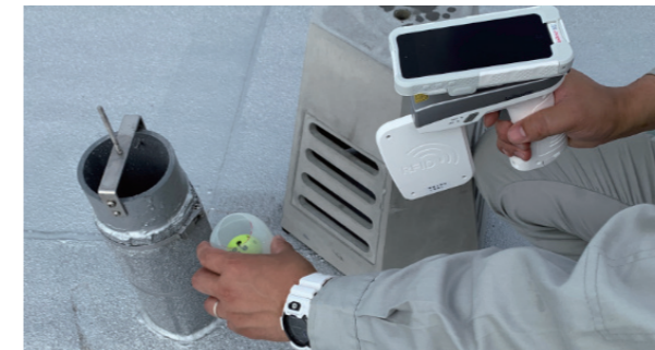
RFIDタグを用いた設備検査の様子
