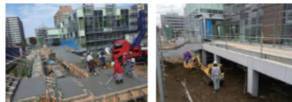
長谷工テクニカルセンターでのH-BAコンクリート施工風景
