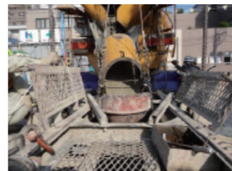
杭コンクリート打設
