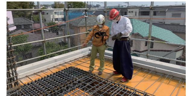
「スパイダープラス」を活用し、検査時すくの指摘が可能に
