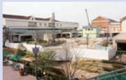
工事中の 「にしまち」
