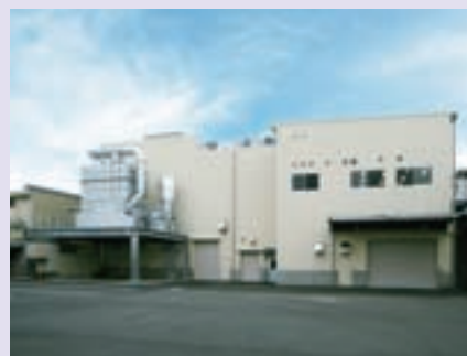
亀岡工場新棟外観
