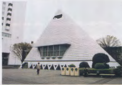
取り壊されるピラミッド校舎
