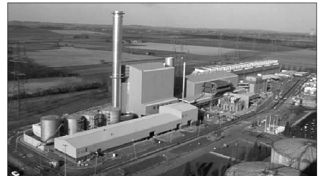
図 3 実際のプラントの外観
