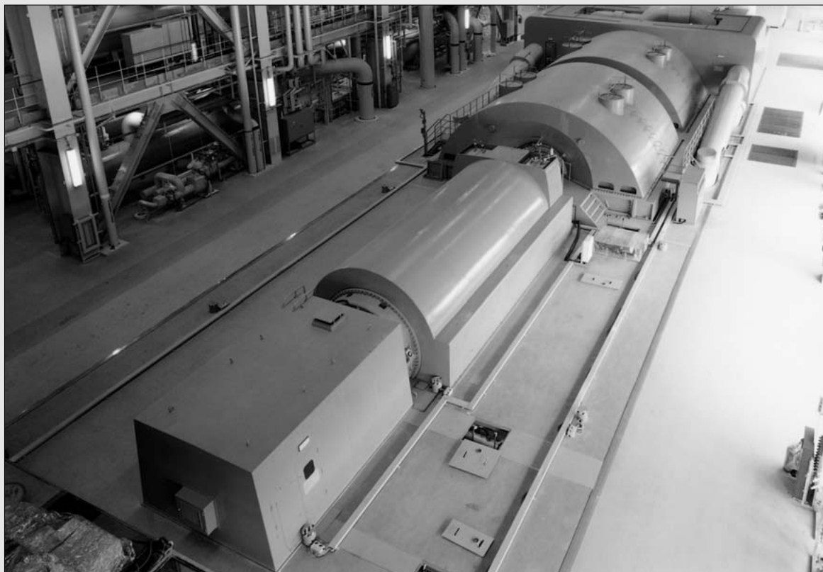
周波数 50 Hzでは国内最大容量 670 MVAの水素冷却タービン発電機
