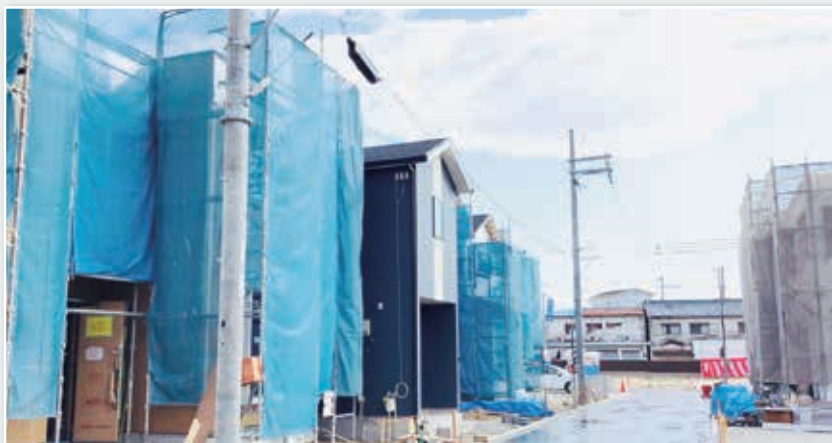
<建築工事風景>
