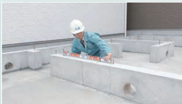
<基礎完了検査風景>
