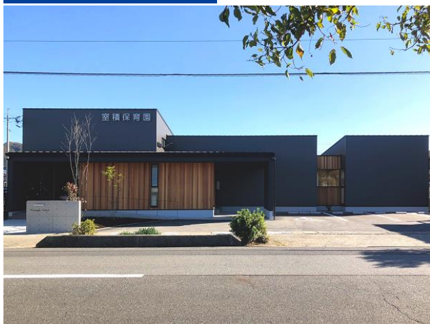
保育園新築工事
