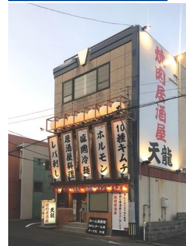
店舗新装工事
