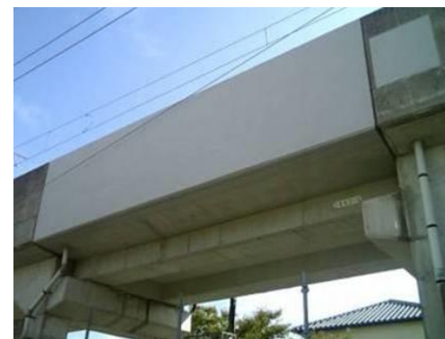
はく落防災コーティング
