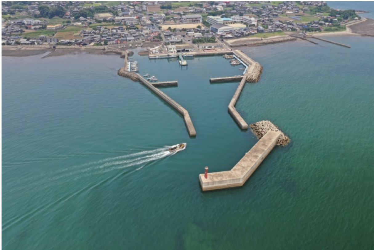
布津漁港の遠景（長崎県南島原市） （当センター長崎支所において撮影）
