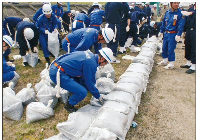
消防団員の台風・集中豪雨等の水防活動（土のう積み）
