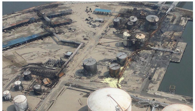
東日本大震災における製油所の被害状況 (宮城県多賀城市：塩釜地区消防事務組合消防本部提供)
