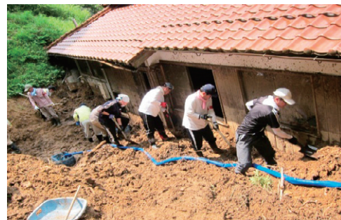
ボランティアによる土砂の撤去作業 (写真提供：山口市社会福祉協議会)
