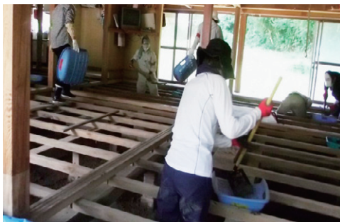
ボランティアによる土砂の撤去作業 (写真提供：山口市社会福祉協議会)
