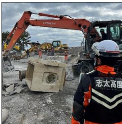
【道路啓開訓練の様子】
