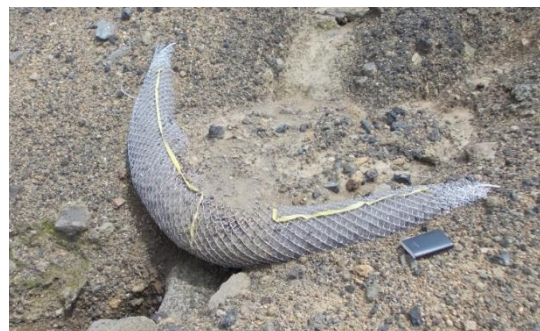
図(1)-6 クレセントロールの設置状況
