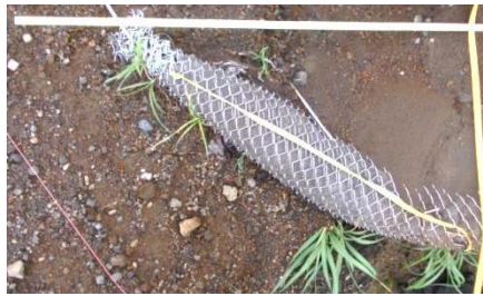
図(1)-44 設置後一年が経過したクレセントロール ハチジョウススキの定着が見られる。
