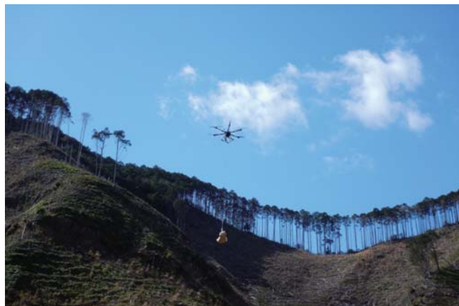
運搬用ドローンを使用した植栽資材運搬
