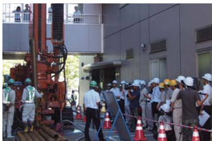
地中熱ボアホール工事見学会
