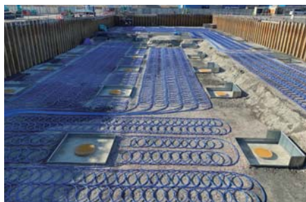
スlinky式コイル埋設
