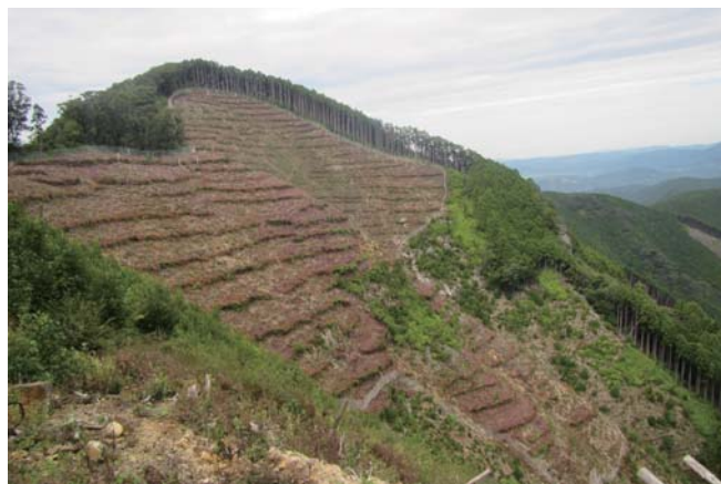
植栽完了現場
